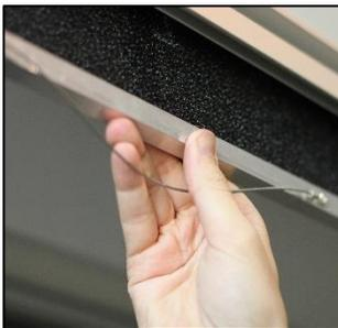
Danach lässt sich das Funktionsprofil öffnen und der Filter nach unten entnehmen.
